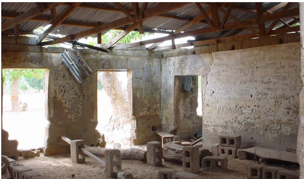
Figuur 3: het te renoveren schoolgebouw
